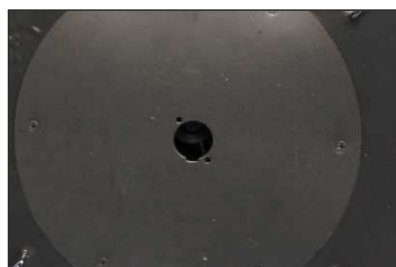
Fijación interior del cable
