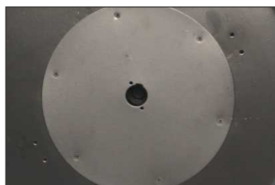
Fijación interior del cable
