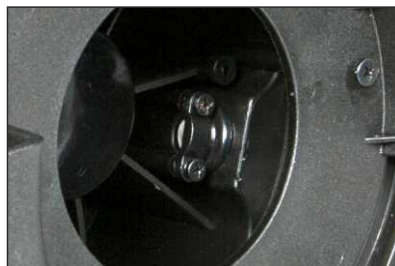
Fijación interior del cable
